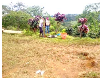
Figura 7. Proceso de construcción del parque
