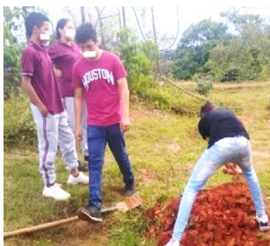
Figura 6. Preparación del terreno
